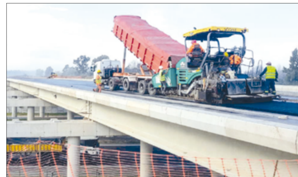
En esta nueva etapa hubo que modificar el proyecto original, ya que la administración anterior no contemplaba el tránsito de camiones ni las subidas ni bajadas en la Autopista Ezeiza-Cañuelas.
