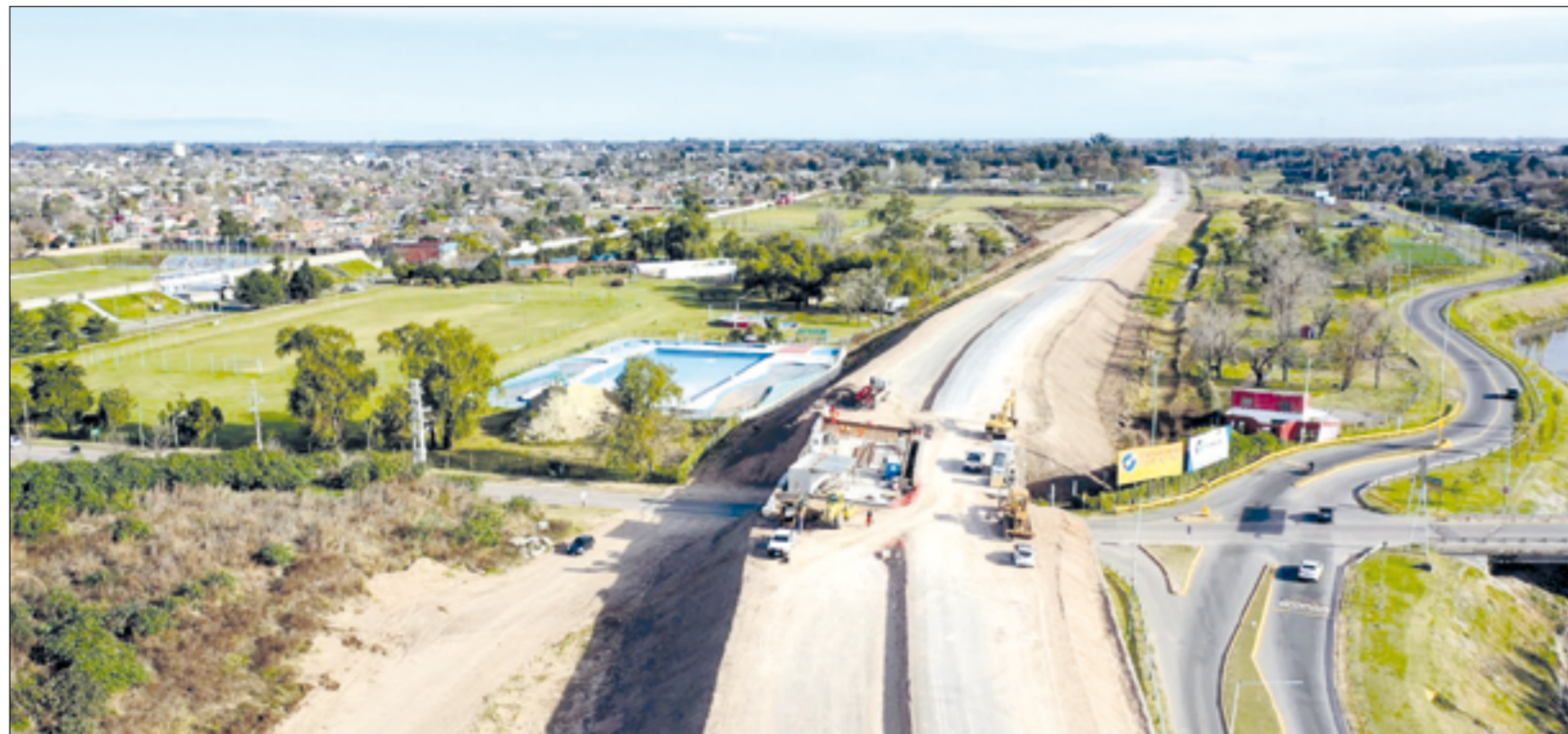
Vista aérea, Obras de extensión, segunda etapa de la autopista del Buen Ayre.
