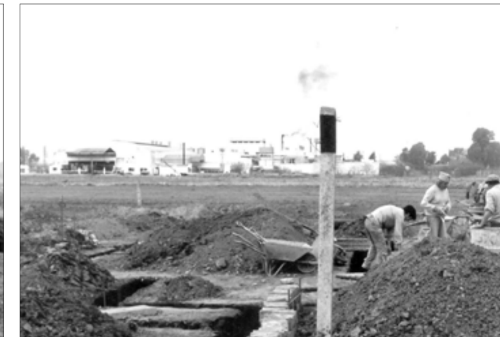
Construcción de los vestuarios en la actual sede de calle Pellegrini.
