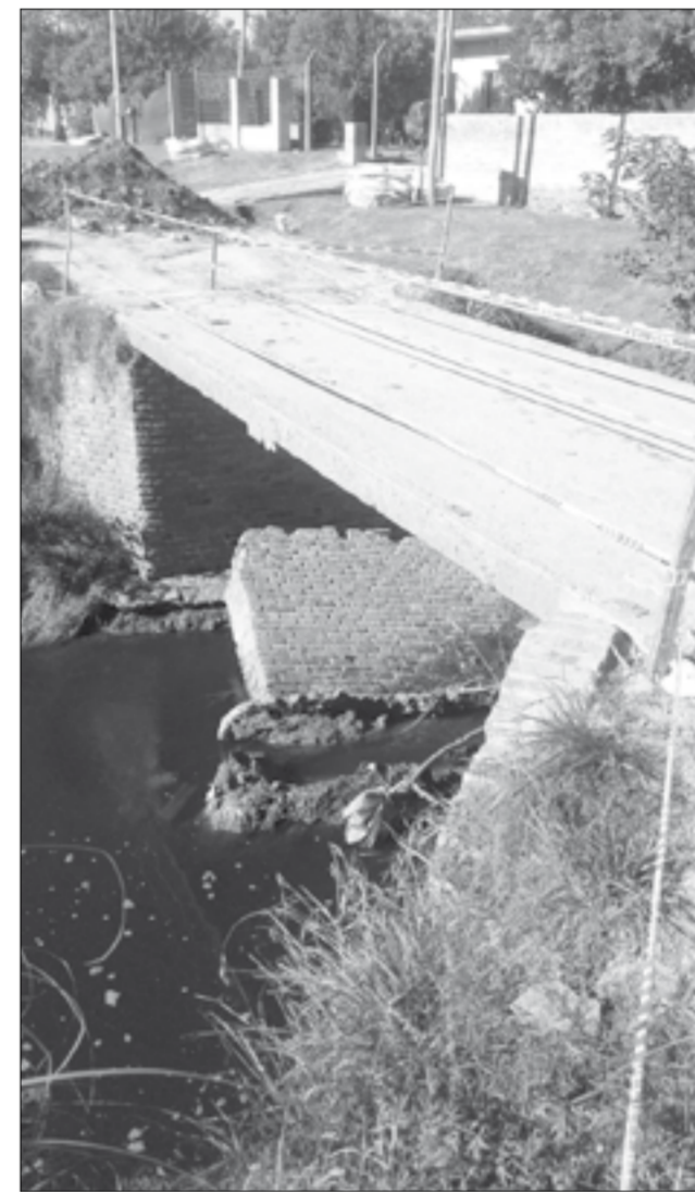
Puente de Combate de los Pozos con el soporte central derrumbado.
