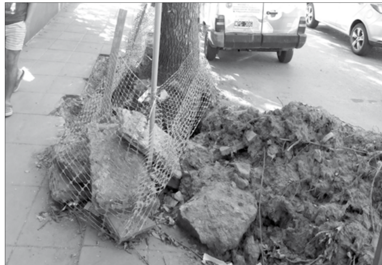
En Rivadavia casi Del Carmen repararon una pérdida de agua y dejaron un pozo con un árbol mutilado.
