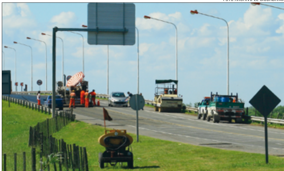
Obreros trabajando sobre la autopista Ezeiza-Cañuelas.
