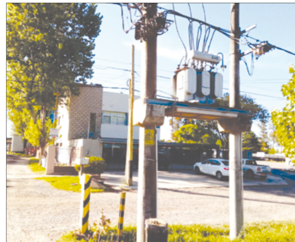
Pedidos y quejas de los vecinos por el transformador de Catamarca casi Kennedy.
