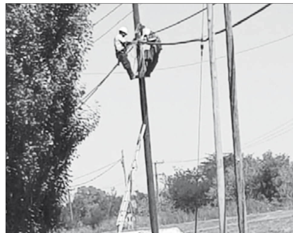
Operarios en plena tarea de restitución de los cables de teléfono hurtados hace casi dos meses.
