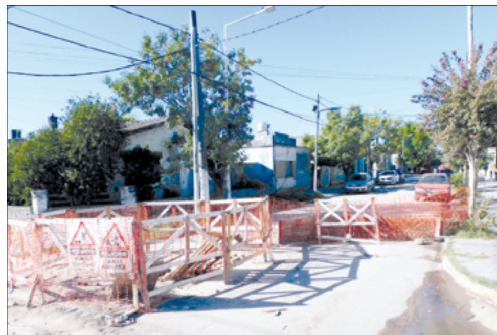
De esta manera dejaron la obra paralizada
