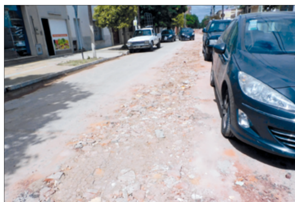
Una hilera de escombros divide la cinta asfáltica.
