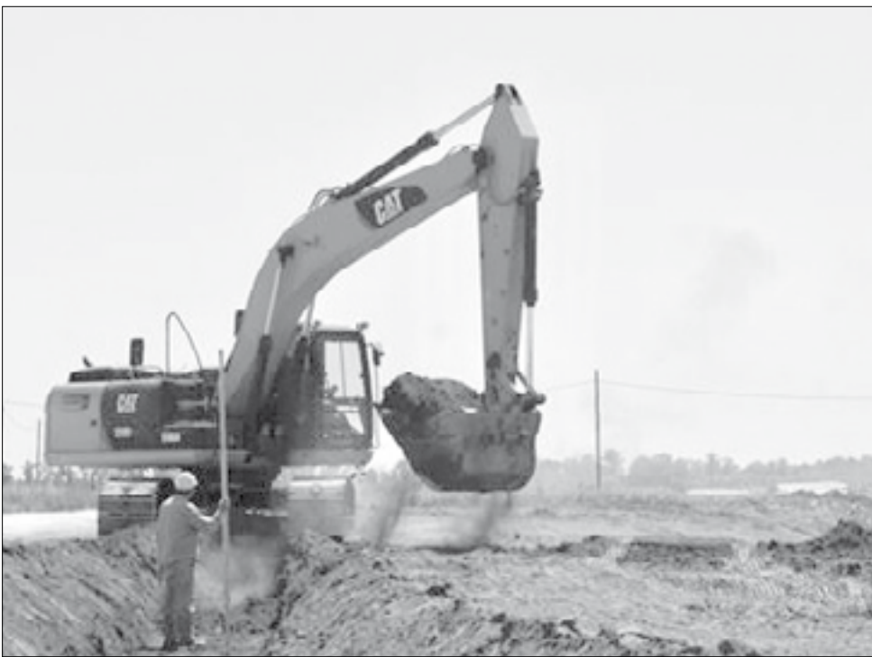
Máquinas trabajando a destajo para terminar la obra en los próximos 90 días.
