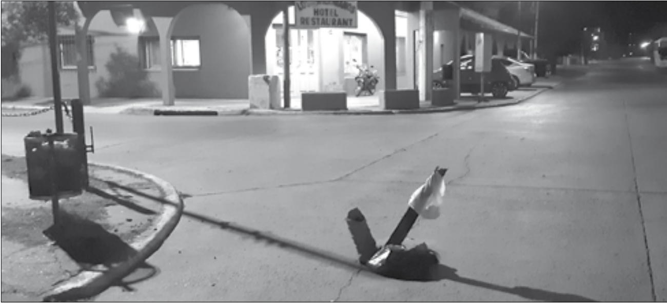
Libertad y la Ruta 205, dejaron señalizando el daño y el peligro potencial.
