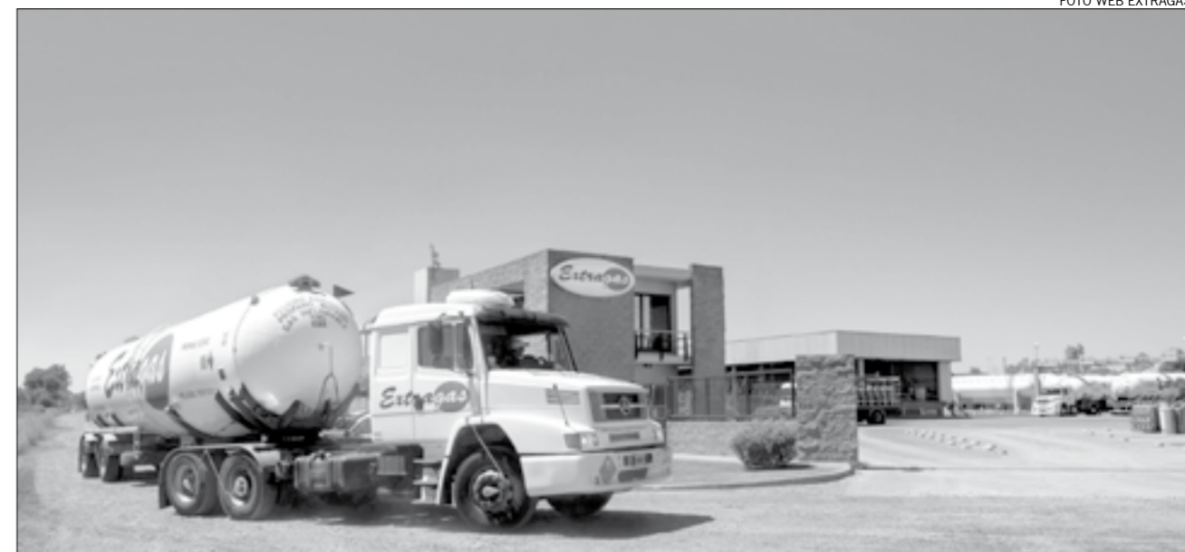
Entrada a la planta de Extragas.
