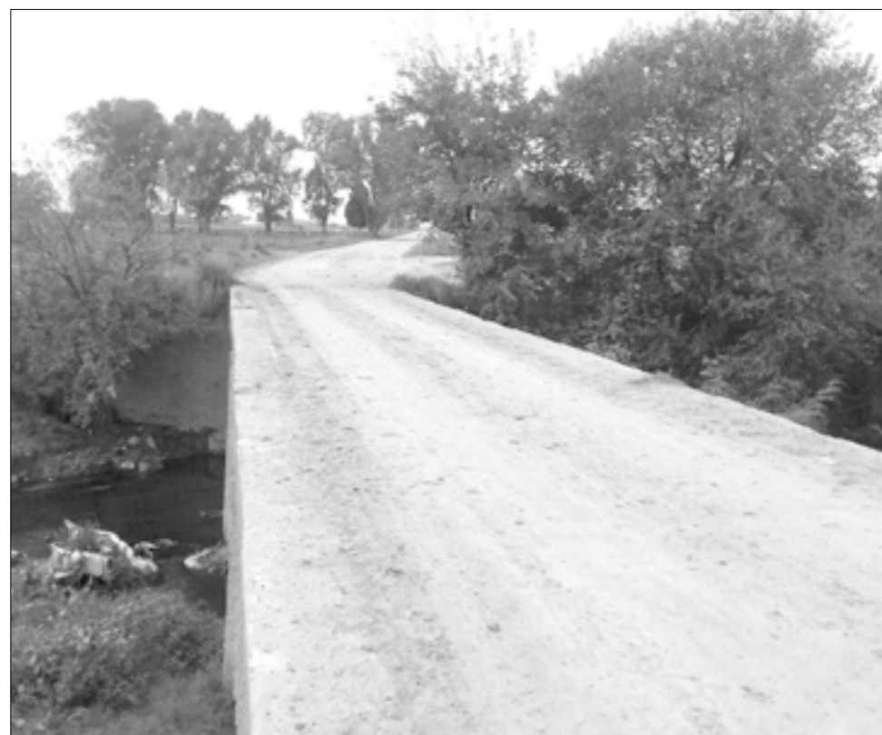
Puente que une Cañuelas con La Matanza.
