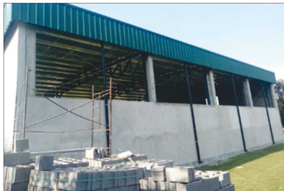
La construcción del Colegio de Oficios entra en una etapa final.
