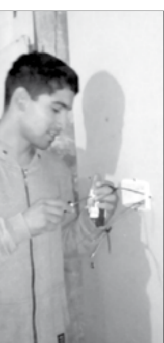
Trabajos de mejoras en la instalación eléctrica en el espacio de la CTEP Las Praderas.
