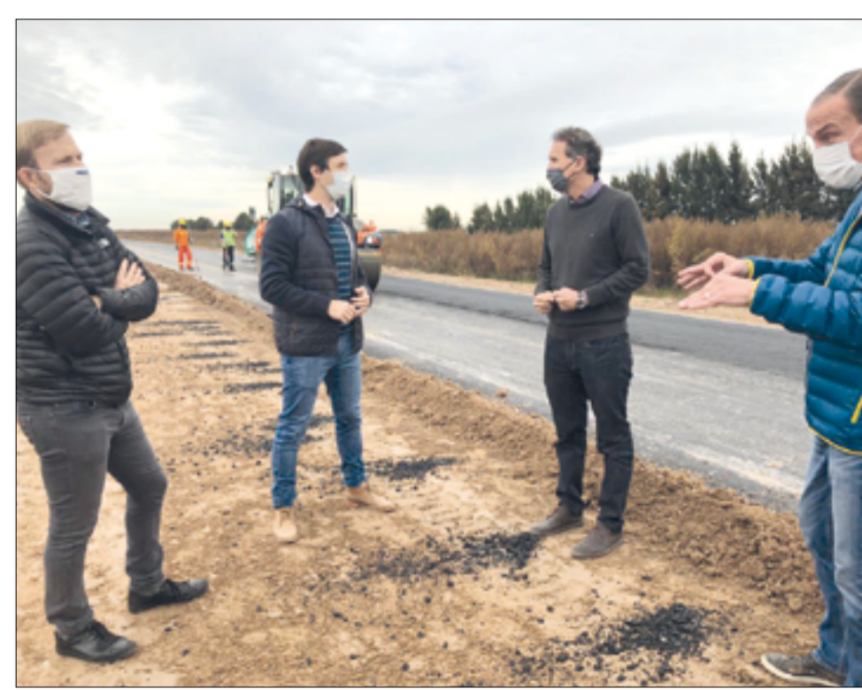
Una vez concluidos los trabajos se contará con 83 kilómetros conectando el Acceso Oeste con Ruta 2.
