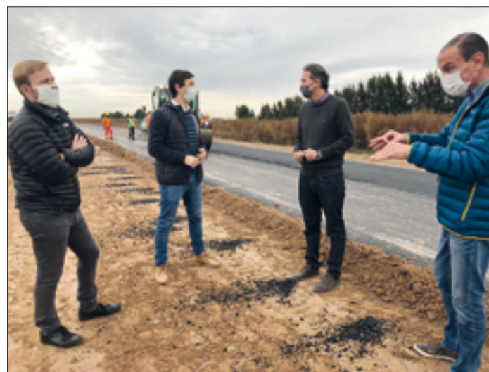
El administrador de Vialidad Gustavo Arrieta visitando el lugar de las obras.
